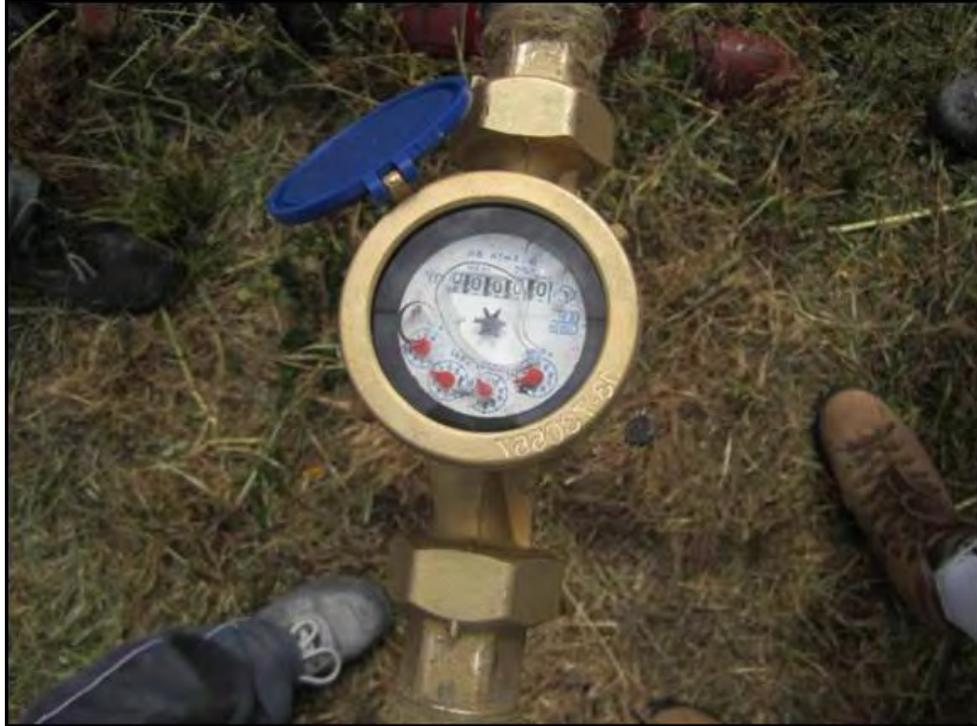
**Figura 6.15: Contatore installato al pozzo PN3 per la misurazione della portata emunta.**
