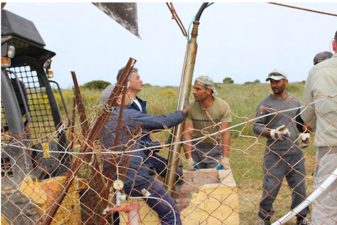
**Figura 6.14:** Immagine della pompa che è installata al pozzo PN3, la sua estrazione è stata necessaria per l'installazione del tubo in plastica per facilitare le misure freatiche.
