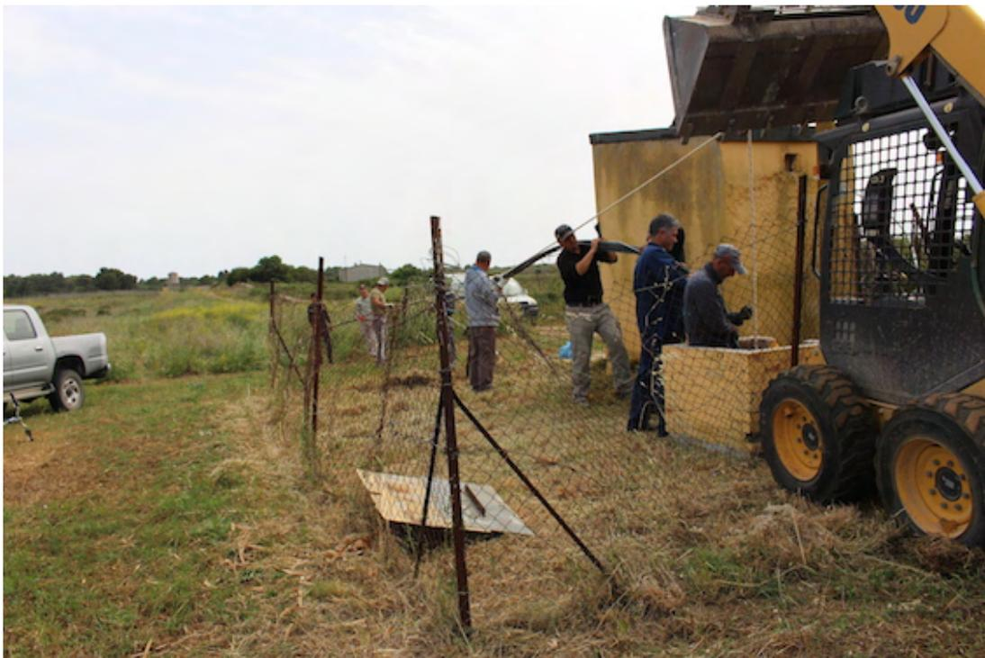
**Figura 6.16: Installazione del tubo in plastica per facilitare le misure freatiche e l'installazione della sonda multiparametrica.**
