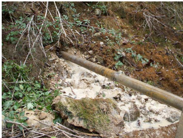
FOTO 6 – fase di perforazione a carotaggio continuo
