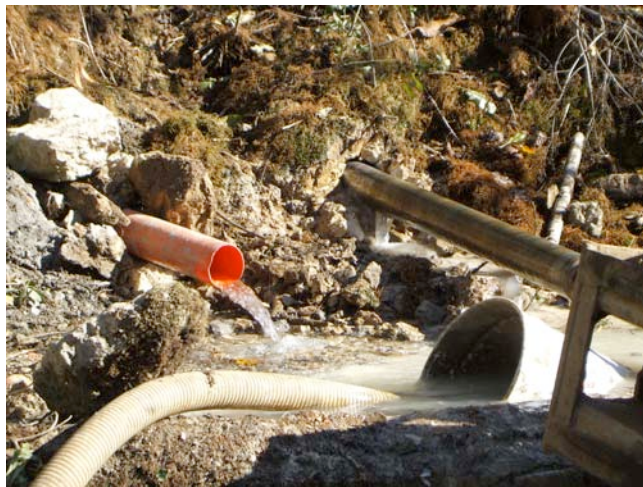
FOTO 8 – realizzazione del secondo dreno
