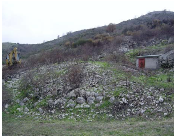
FOTO 3 – fasi di lavorazione per la verifica dello scorrimento delle acque nel detrito di versante
