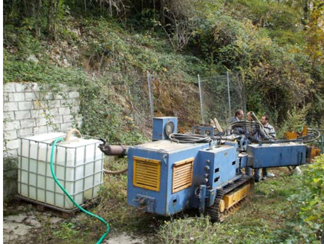
FOTO 5 – posizionamento sonda per la perforazione
