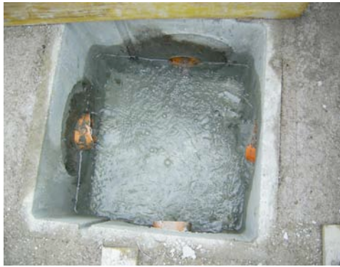
FOTO 4 – particolare dell'opera di presa realizzata
