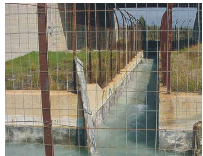
Figura 20 Sorgente idrotermale minore posizionata in corrispondenza di un cavalcavia dell'Autostrada del Sole A1
