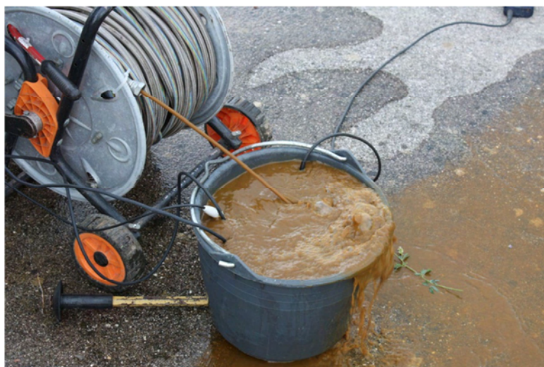
Figura 4.15: Spurgo del pozzo 12F con acqua di color arancione dovuta all'ossidazione del tubo di rivestimento.
