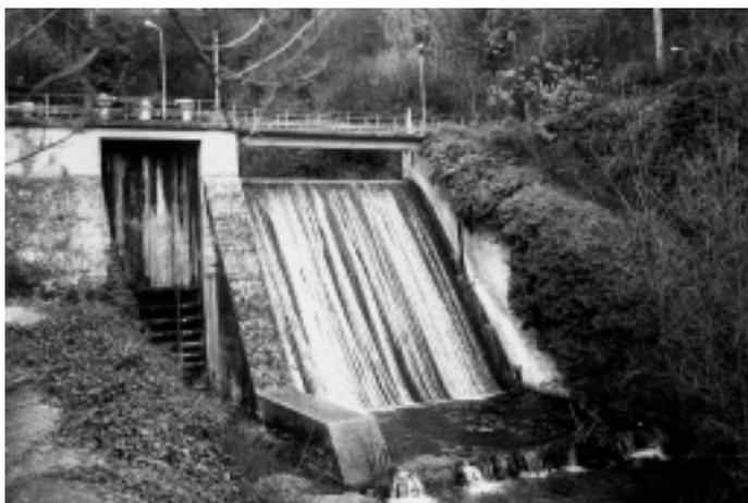
Fig. 4 - Sorgente «Basso Tirino». Opera di captazione vista dal basso. La sorgente è ubicata nell'alveo del Tirino immediatamente a monte della traversa. Le acque sorgive risalgono in pressione fino alla quota di coronamento (262 m): 6 m<sup>3</sup>/s sono derivati dalla condotta idroelettrica; la portata in eccesso trabocca e torna nell'alveo naturale.
