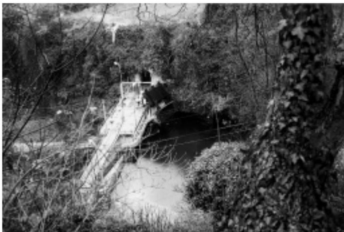
Fig. 3 - Sorgente «Basso Tirino». Opera di captazione vista dall'alto. Una traversa, alta 10 m circa, crea un piccolo bacino che alimenta una condotta idroelettrica di 3 m di diametro. Il bacino è compreso tra l'opera di captazione e una ripida parete di travertino.
